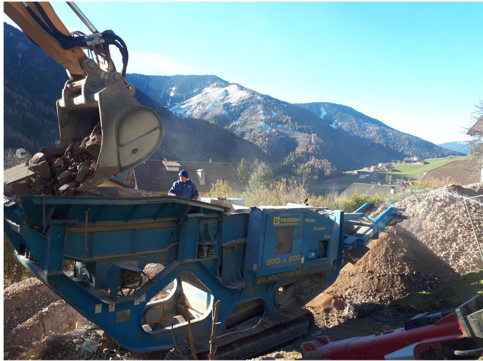
Zerkleinerung des Materials mit mobiler Brechanlage
