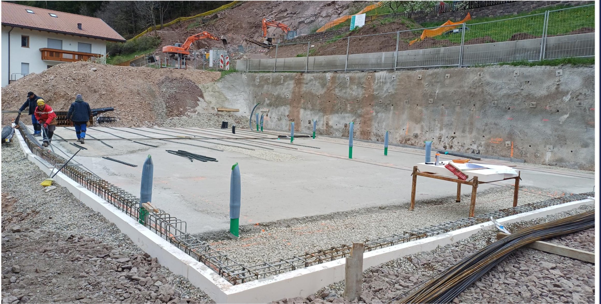
Gießen der Magerbetonplatte am 22. April 2024
