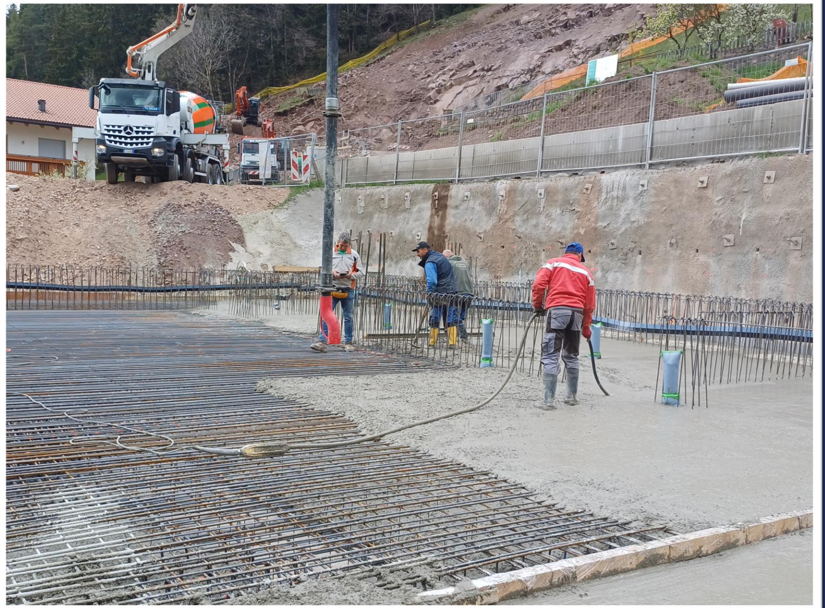
Gießen der Fundamentplatte am 23. April 2024
