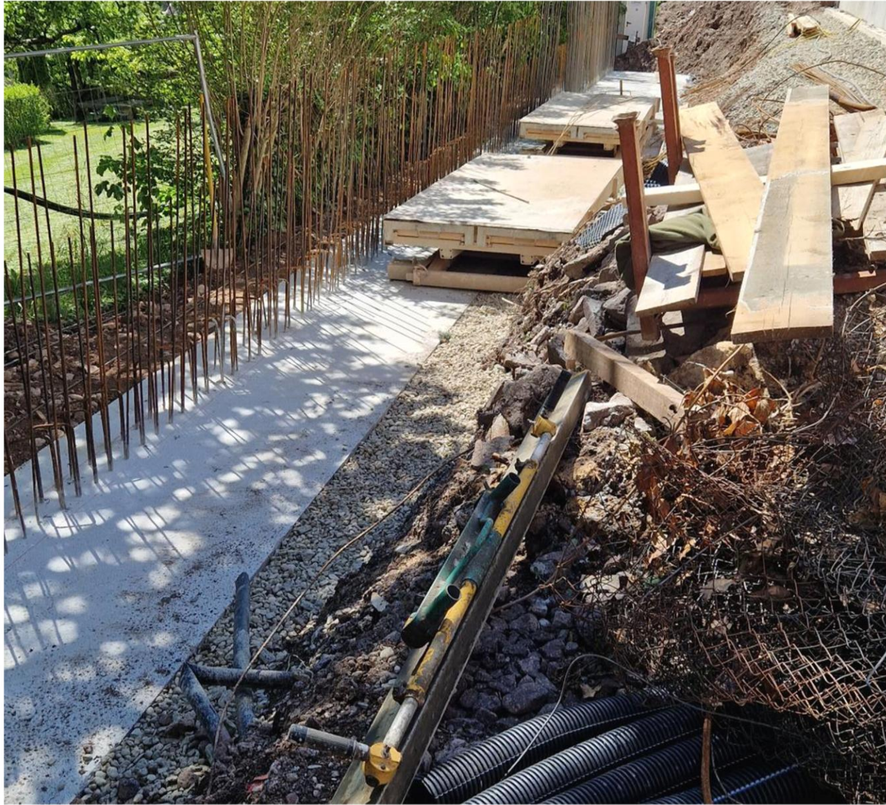
Gießen der Fundamente 1. Teil Rampe am 5. Juni 2024
