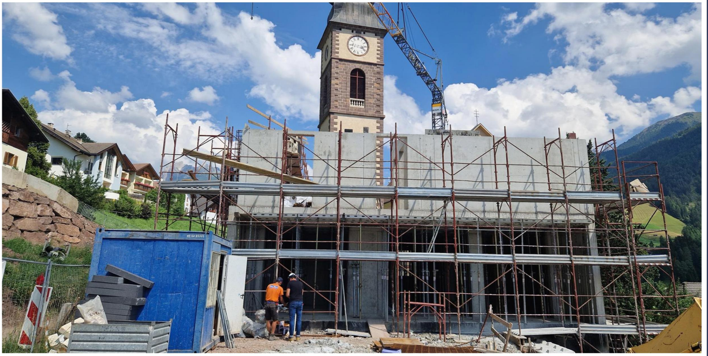
Aufbau der Wände im Obergeschoss Anfang Juli 2024
