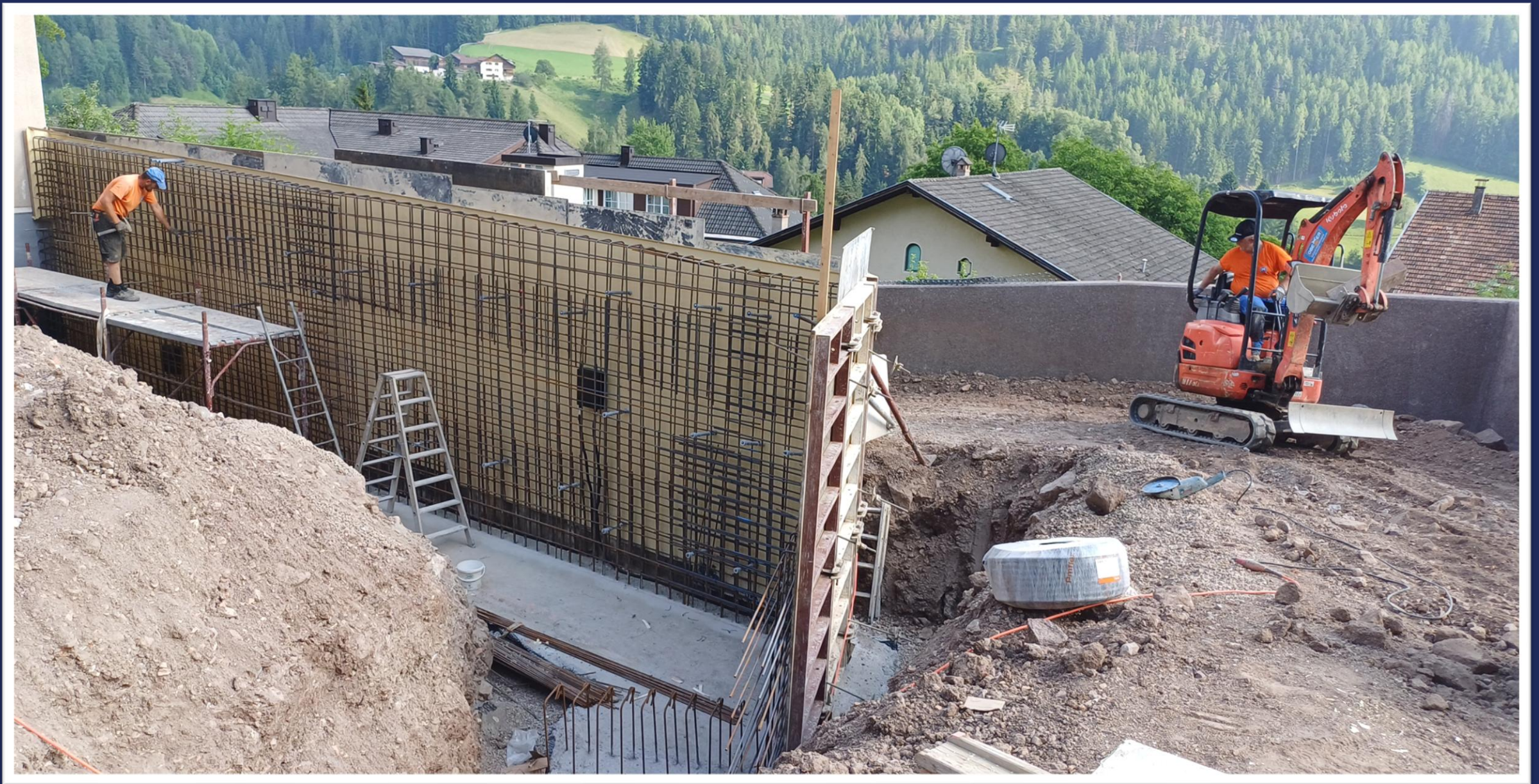
Errichtung der inneren Mauer der Rampe Mitte Juni 2025
