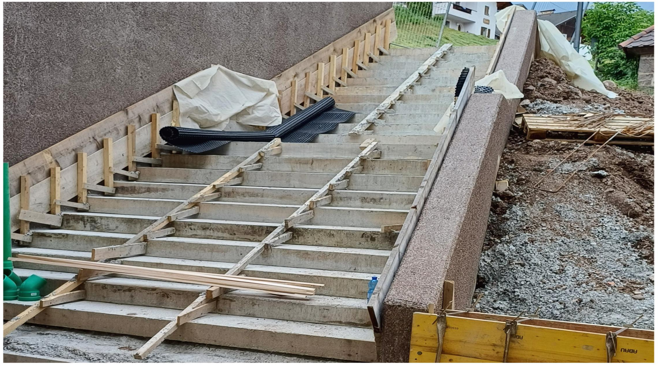
Errichtung der Stiege zum Aufgang Straße Mitte Juni 2025
