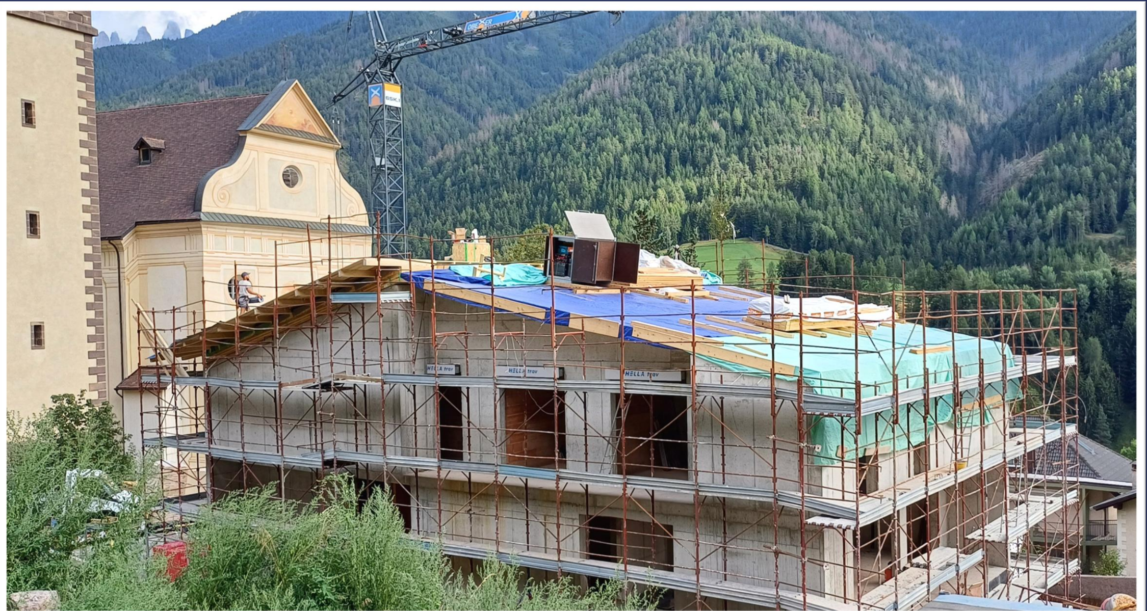
Spenglerarbeiten am Dach ab Mitte August 2024
