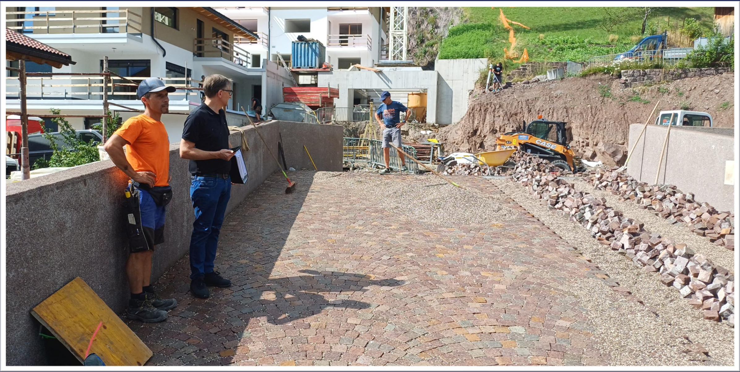
Pflasterung der Rampe Anfang Juli 2025
