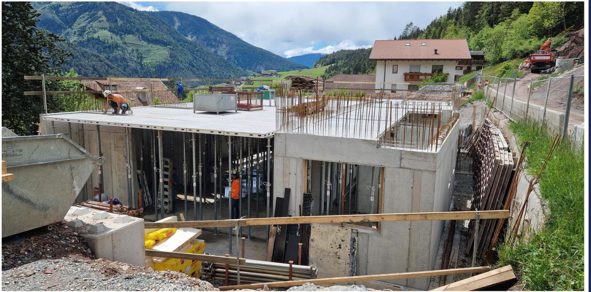
Fertigstellung der ersten Decke am 27. Mai 2024
