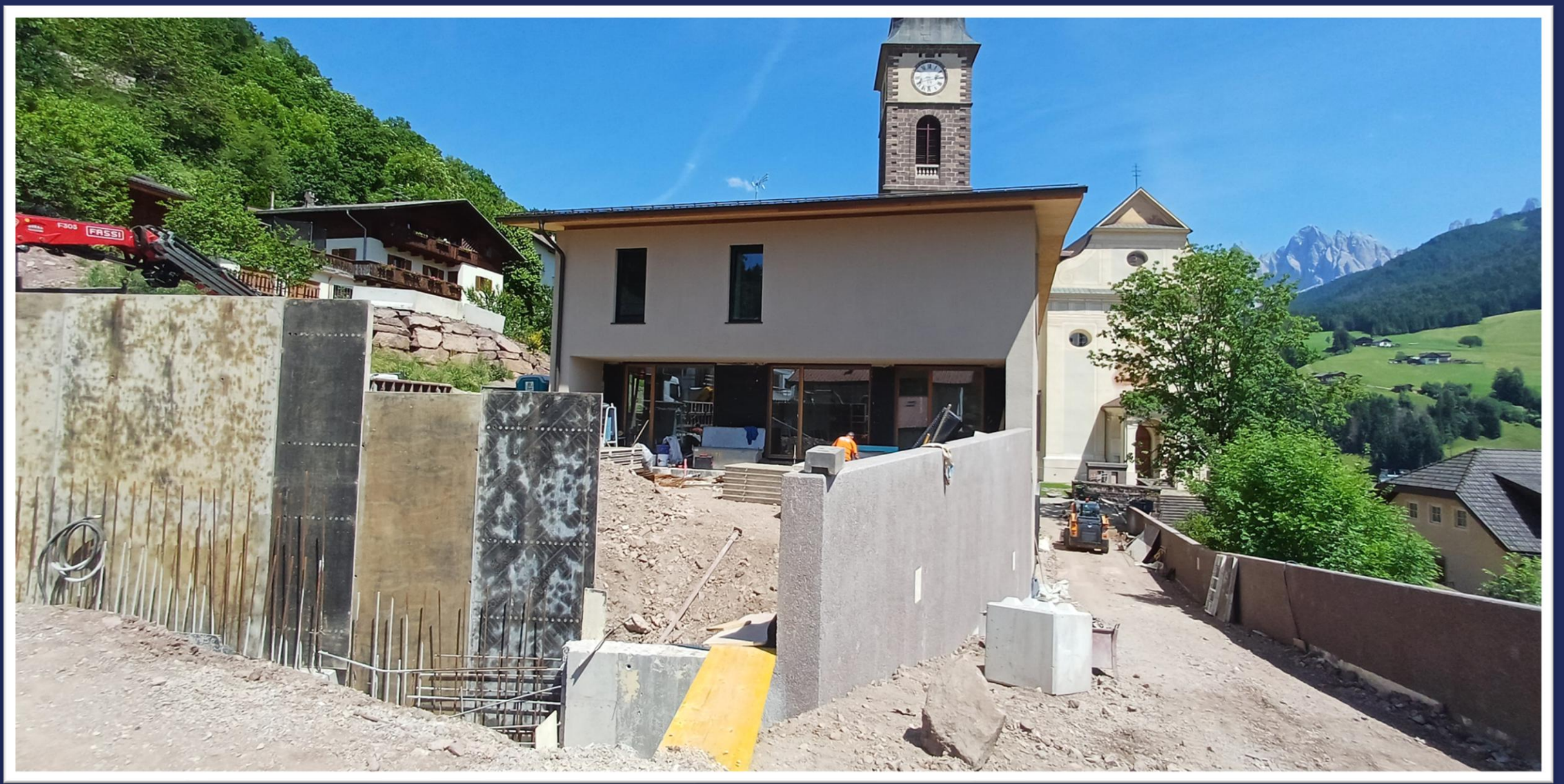
Errichtung der inneren Mauer der Rampe Mitte Juni 2025
