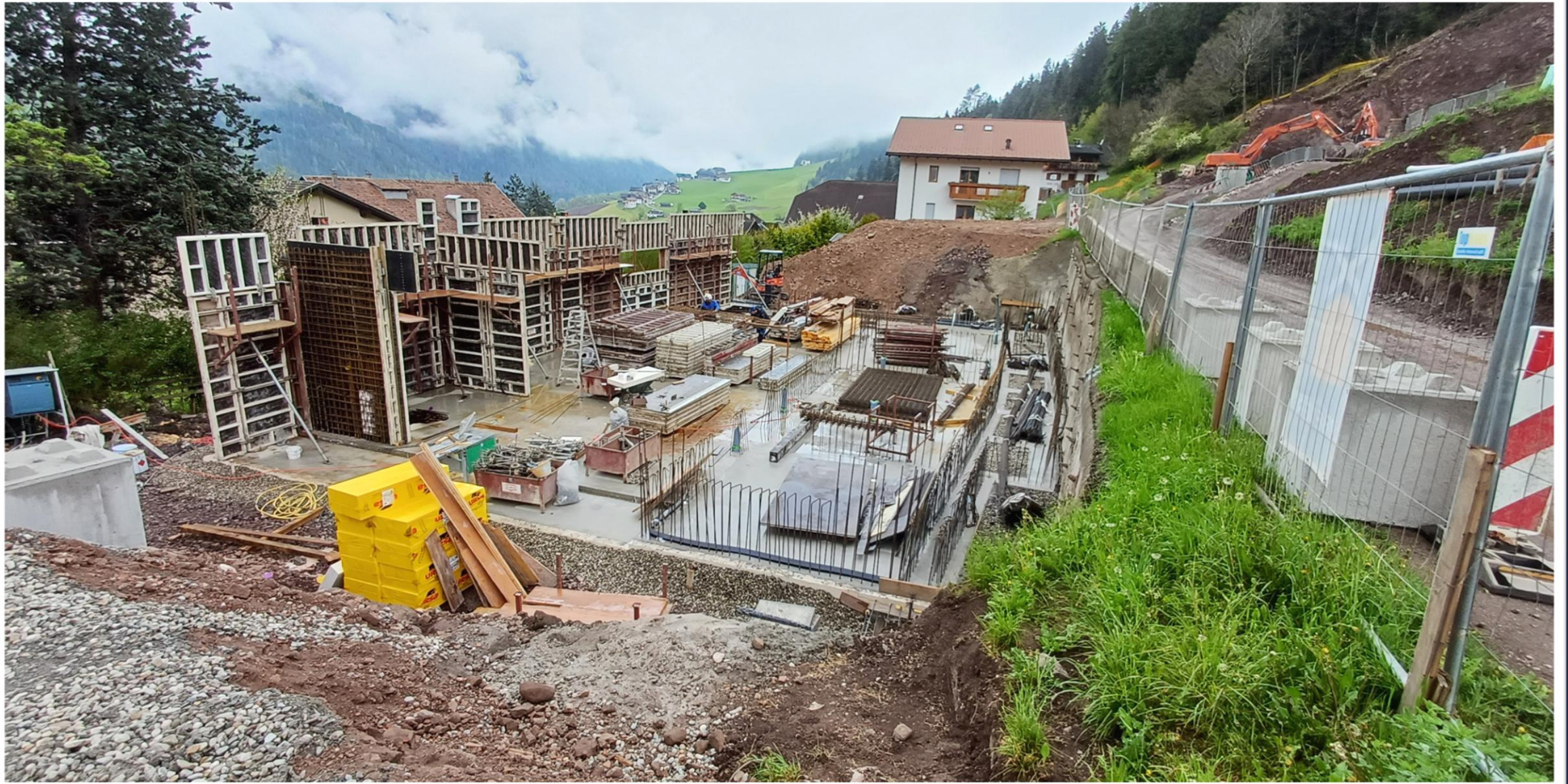
Gießen der ersten Außenwände am 2. Mai 2024
