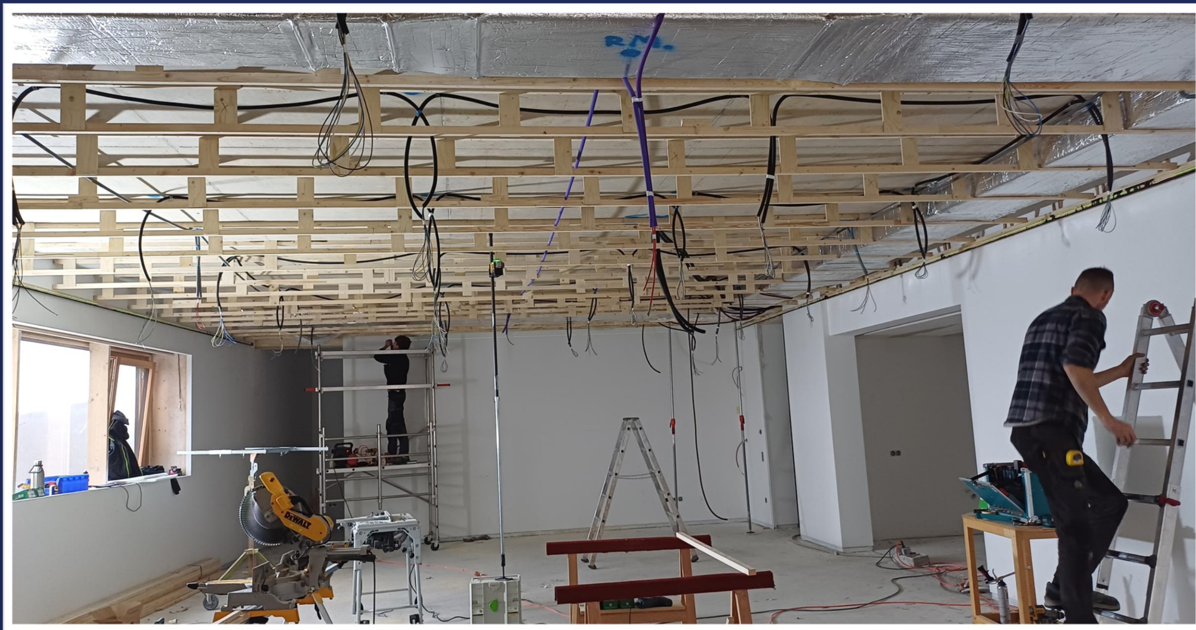
Deckenkonstruktion im Peter&Paul Saal Mitte Jänner 2025
