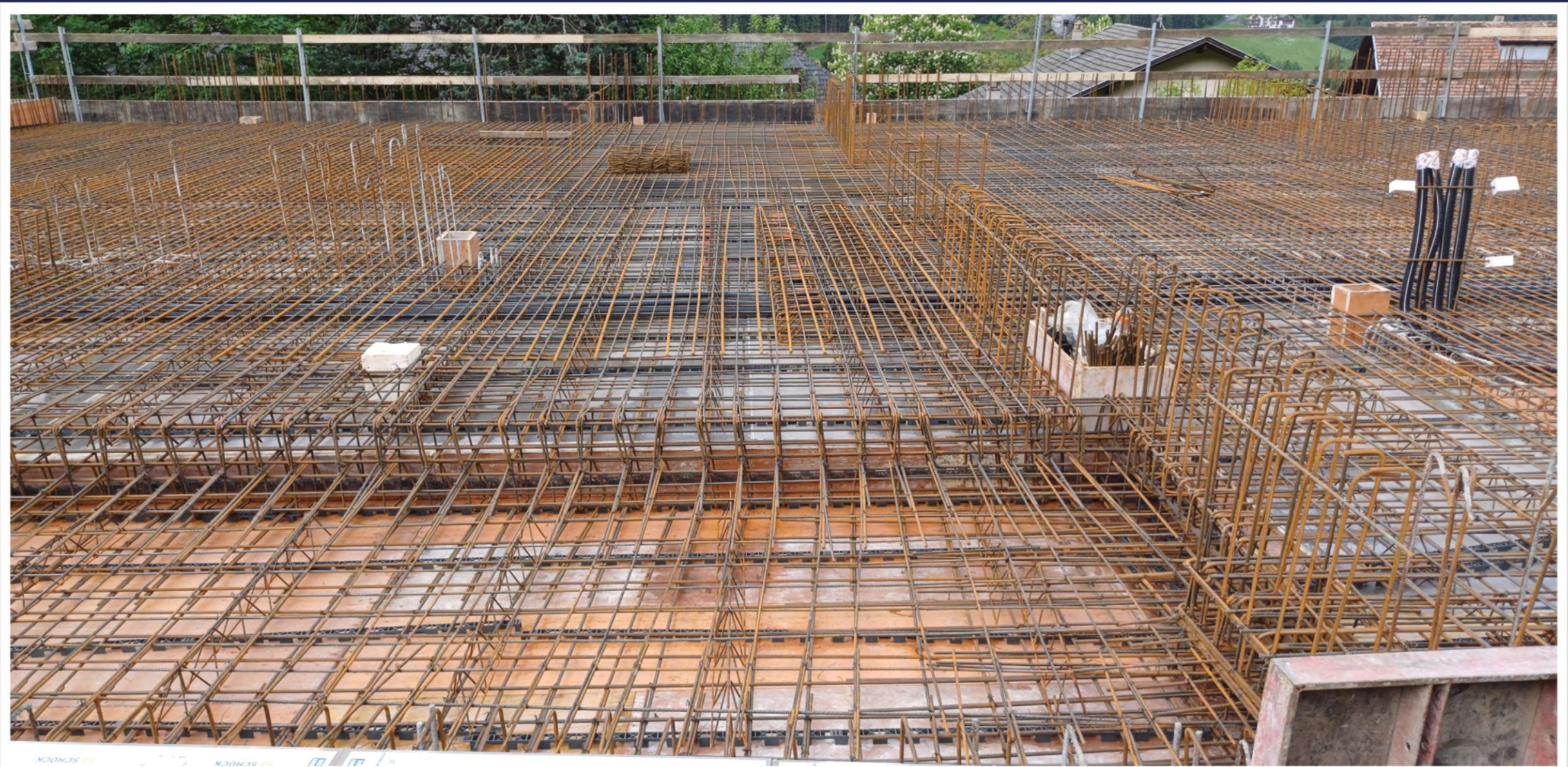
Eisenverlegung der ersten Decke am 25. Mai 2024
