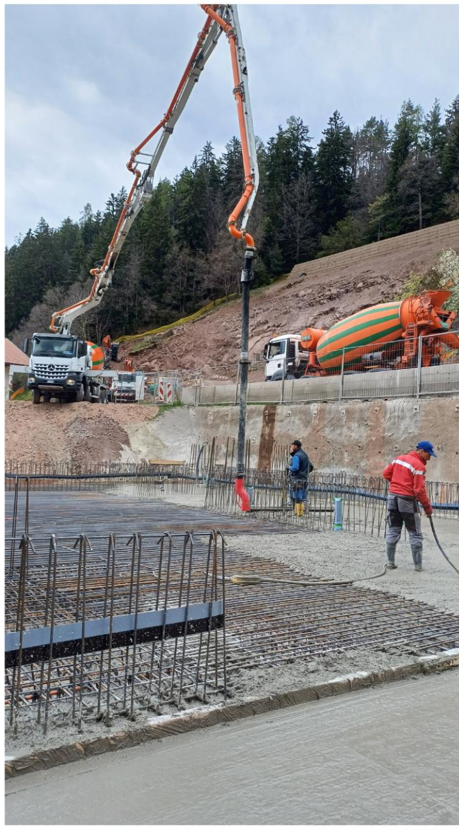
Gießen der Fundamentplatte am 23. April 2024
