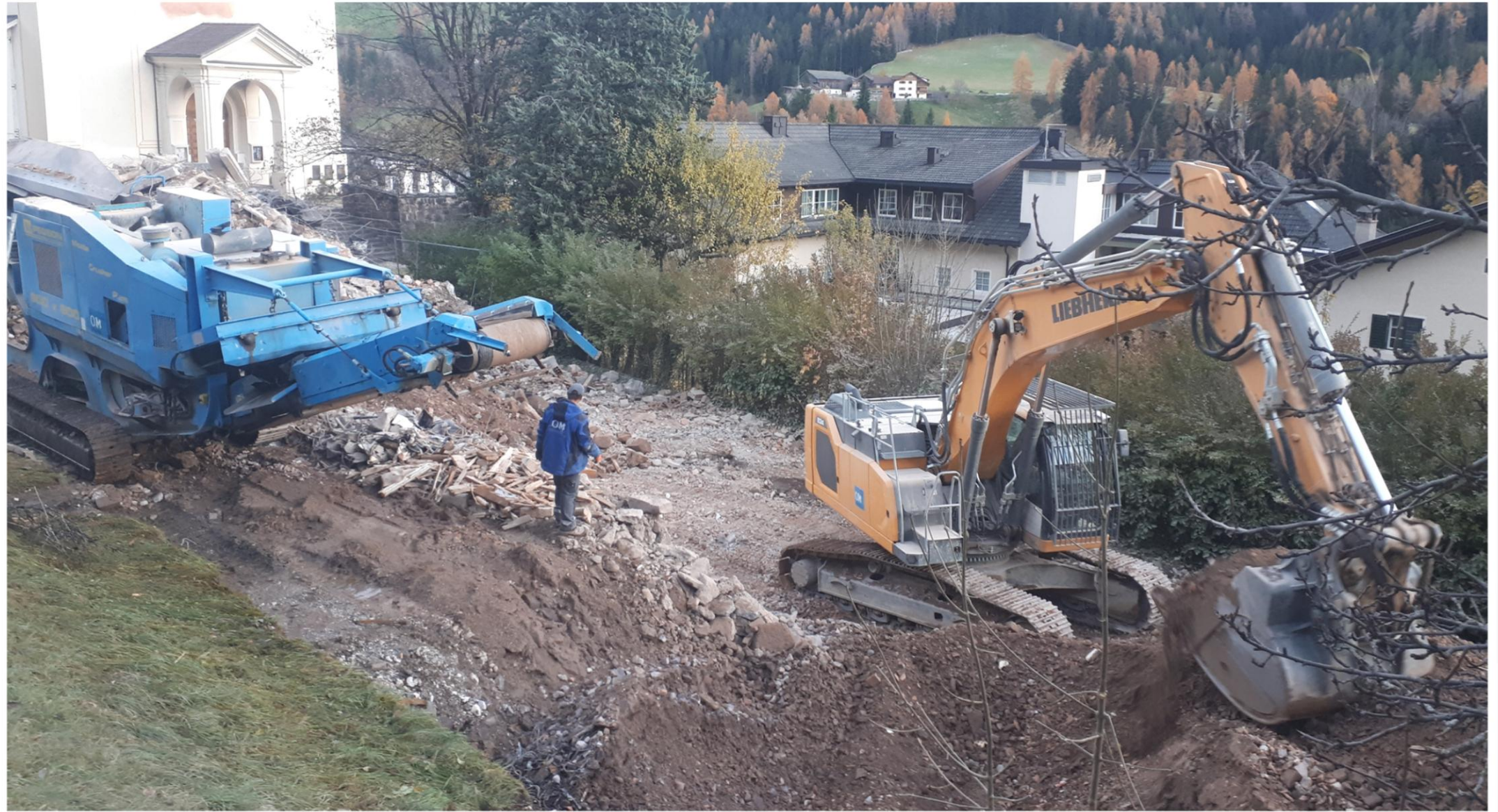
Zerkleinerung des Materials mit mobiler Brechanlage
