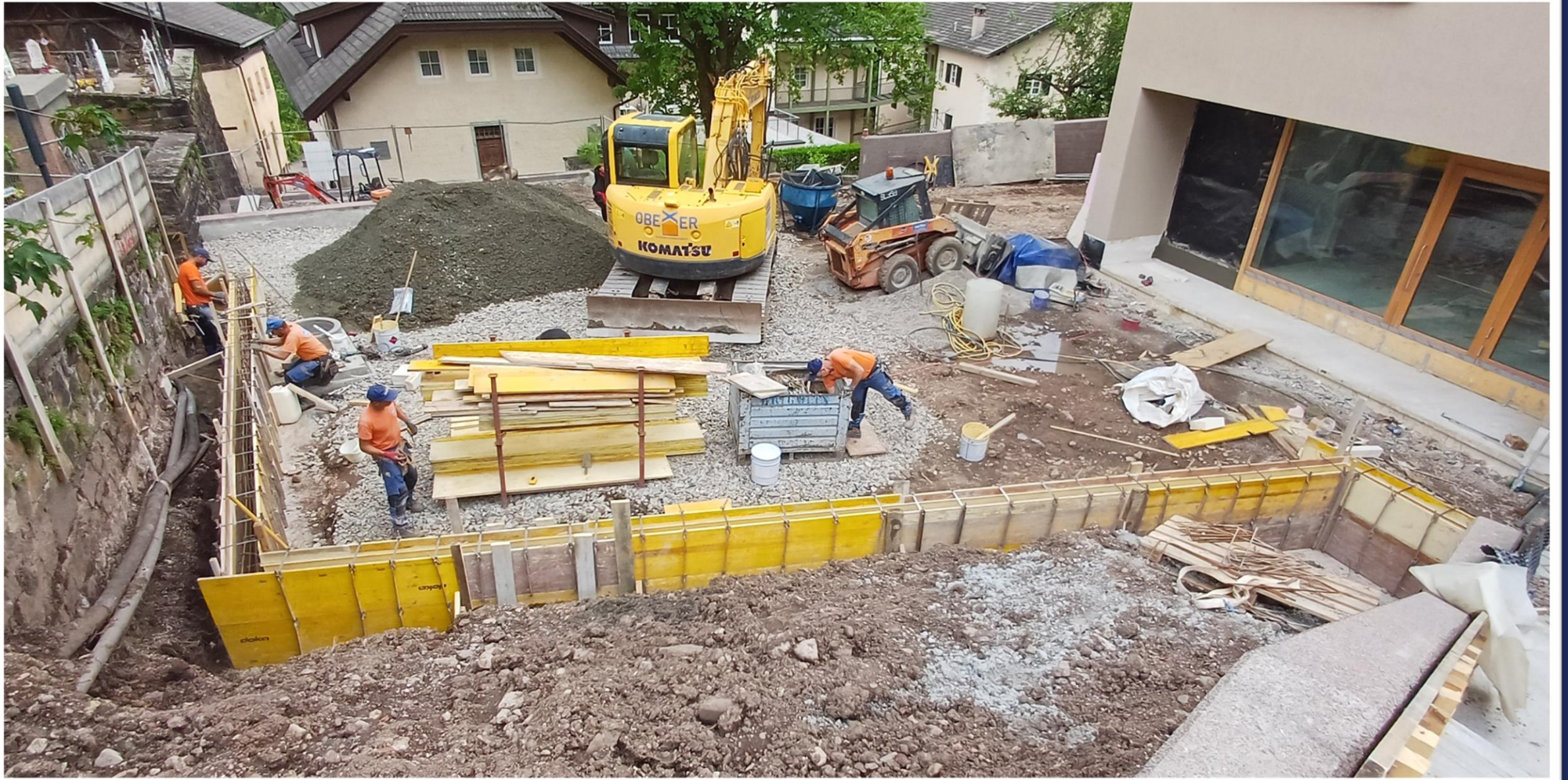
Gestaltung des Pfarrplatzes Mitte Juni 2025
