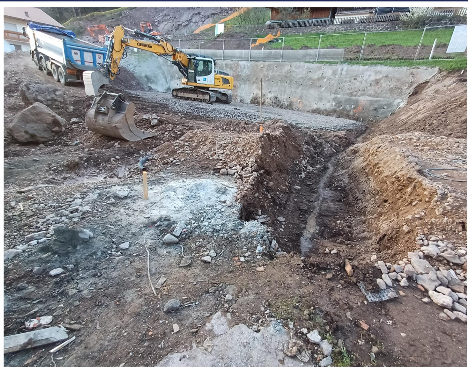
Grundräumung und Trockenlegung Baugrube ab Ende März 2024
