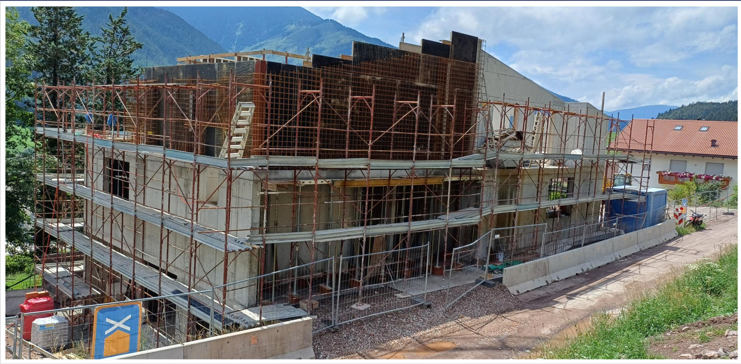
Aufbau der Wände im Obergeschoss Mitte Juli 2024
