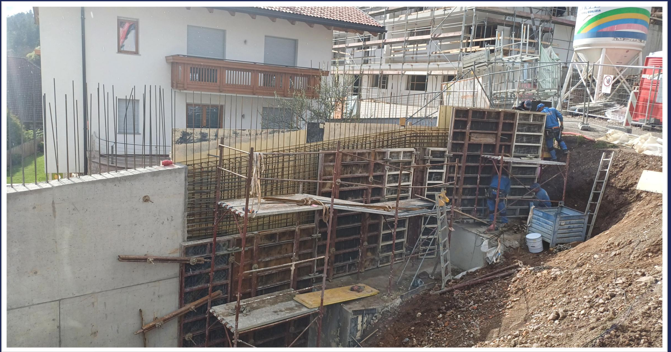
Errichtung der westlichen Rampe Ende April 2025
