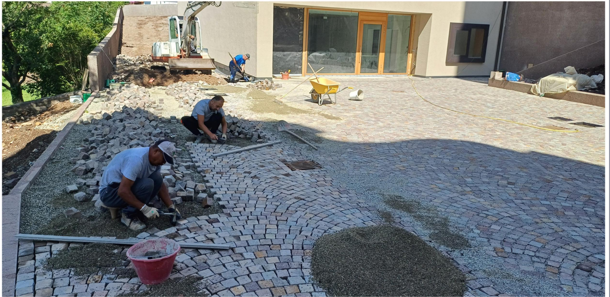
Pflasterung des Pfarrplatzes Ende Juni 2025
