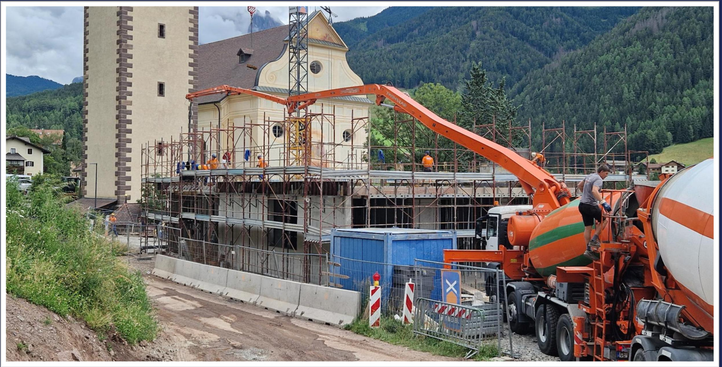
Gießen der 2. Decke (KITA) am 3. Juli 2024
