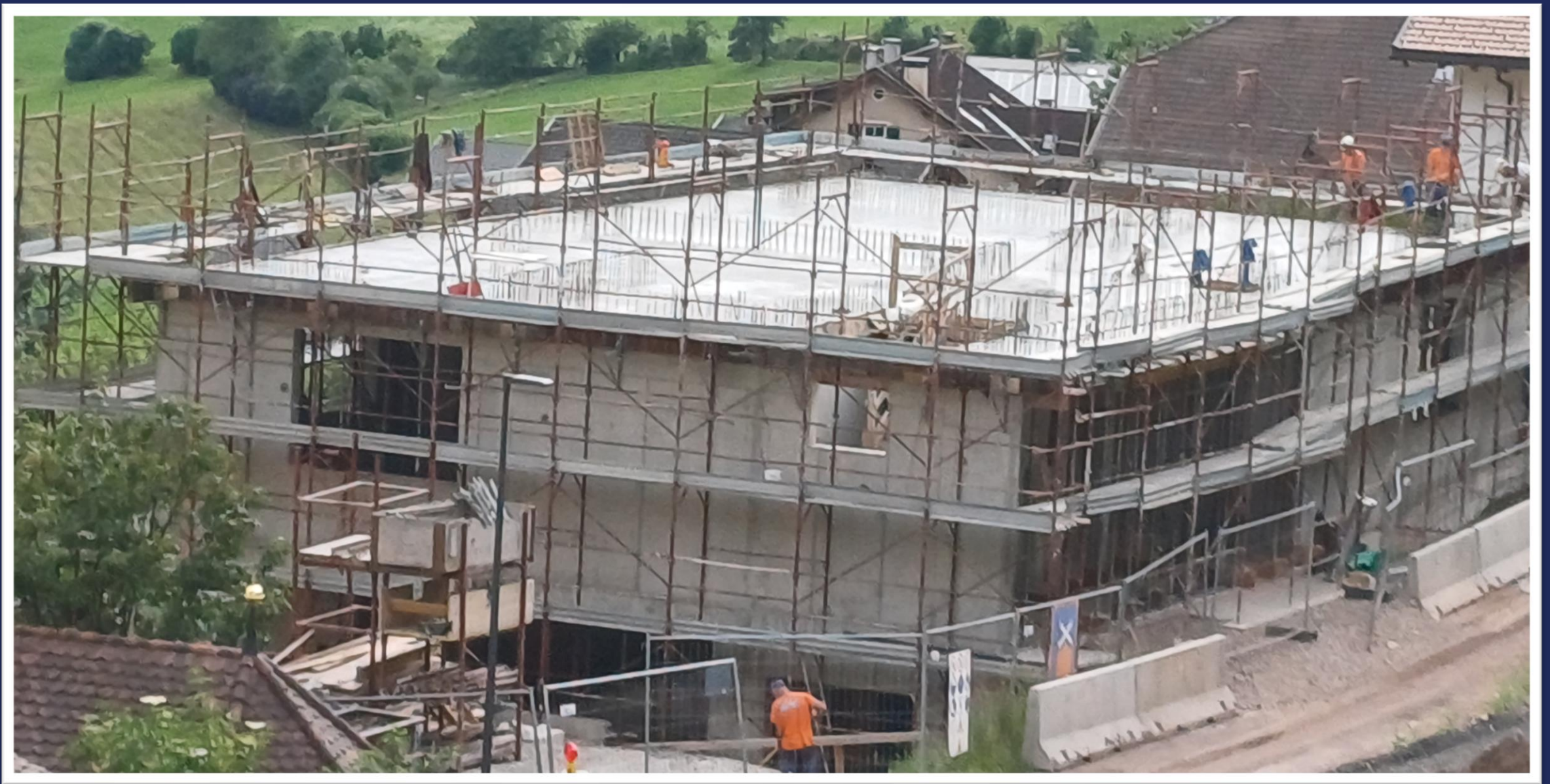
Fertigstellung der 2. Decke (KITA) am 4. Juli 2024
