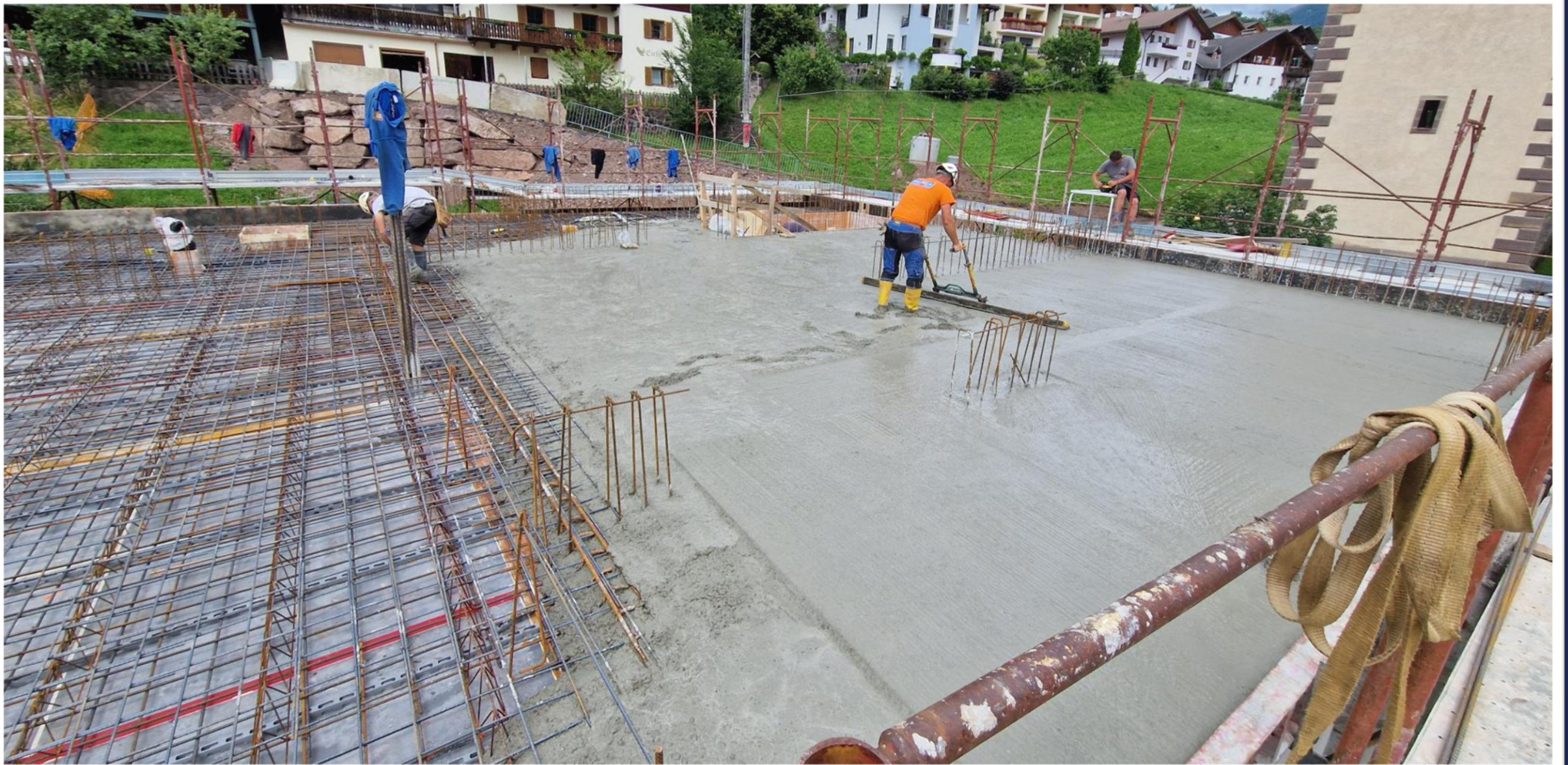
Gießen der 2. Decke (KITA) am 3. Juli 2024
