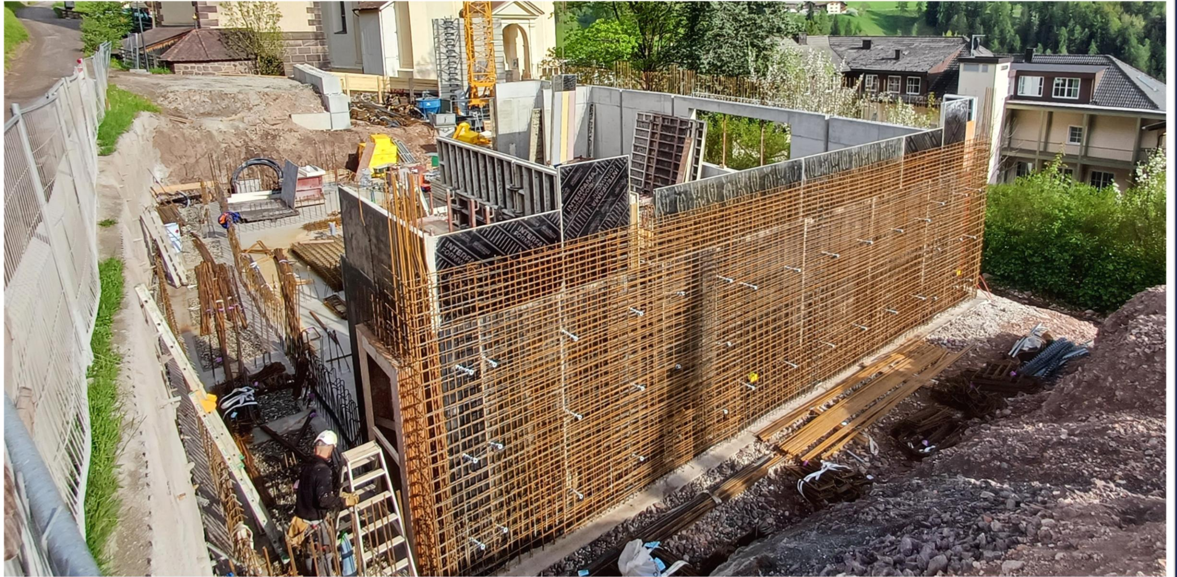
Einschalung der westlichen Außenwand am 6. Mai 2024
