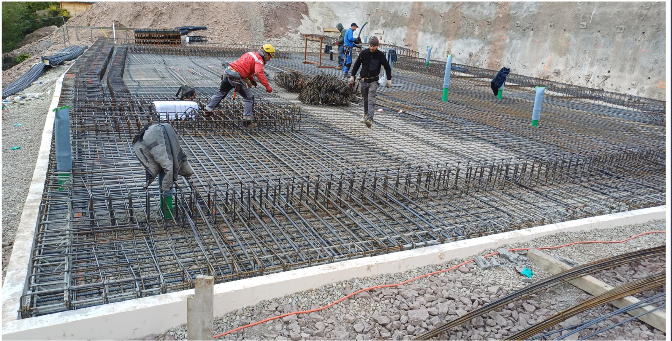
Verlegung der Eisen für Fundamentplatte am 23. April 2024
