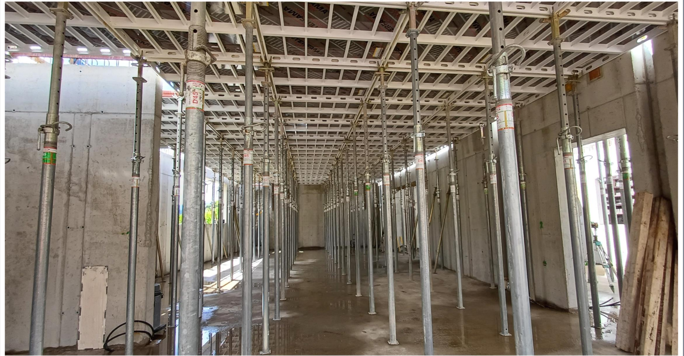
Vorbereitung der ersten Decke am 22. Mai 2024
