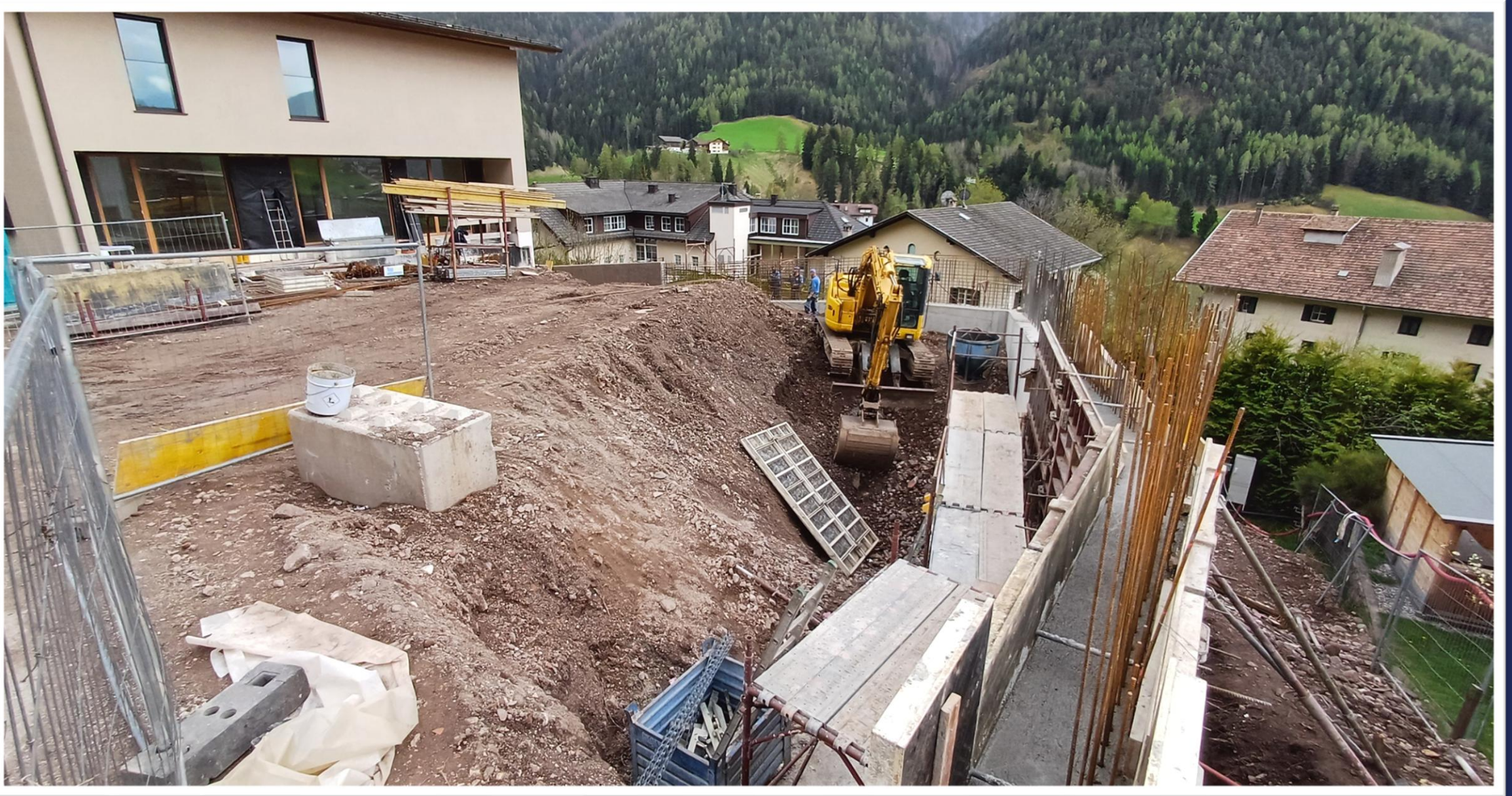
Errichtung der westlichen Rampe Ende April 2025
