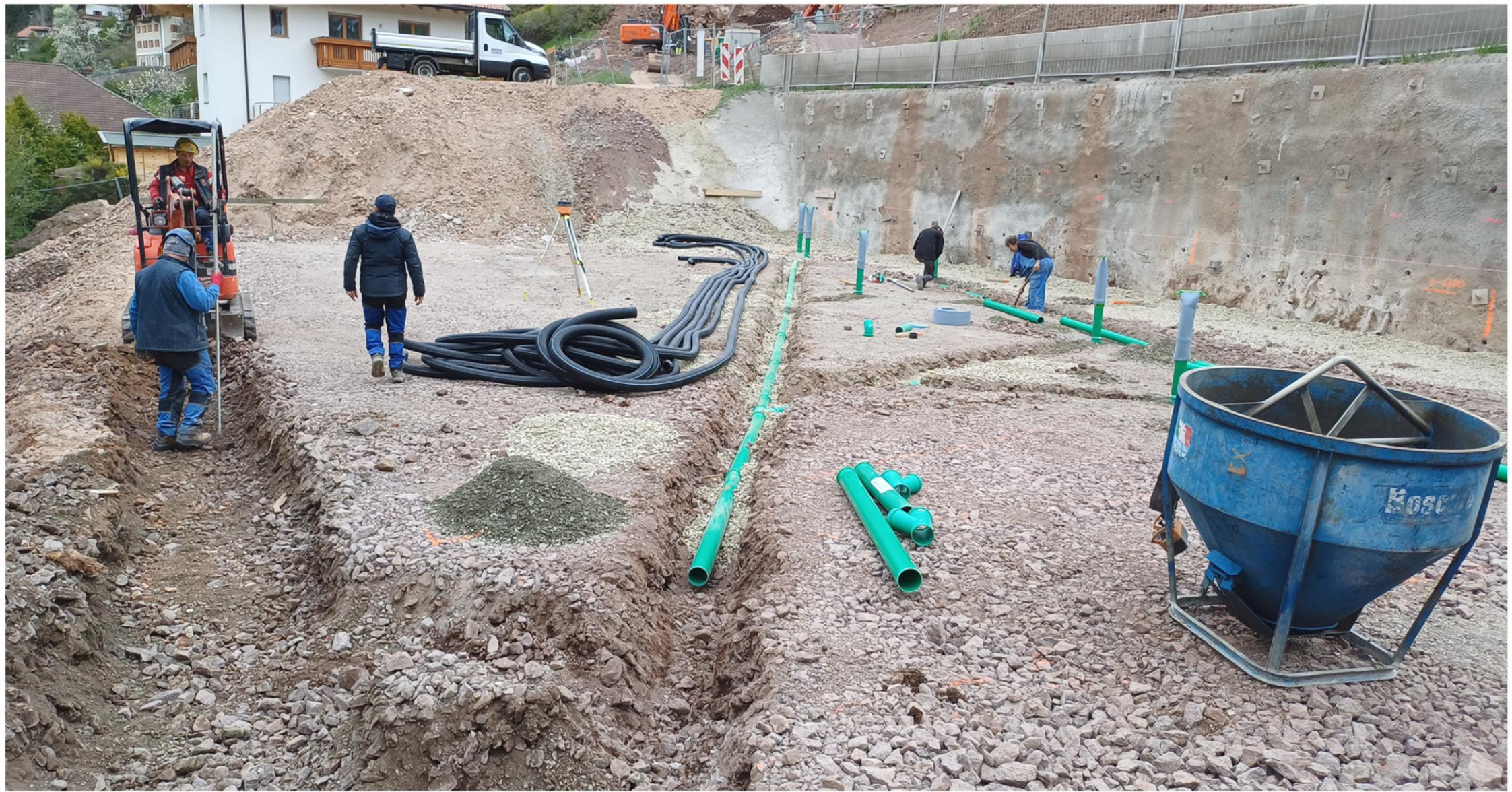
Verlegung der Abflussrohre Mitte April 2024
