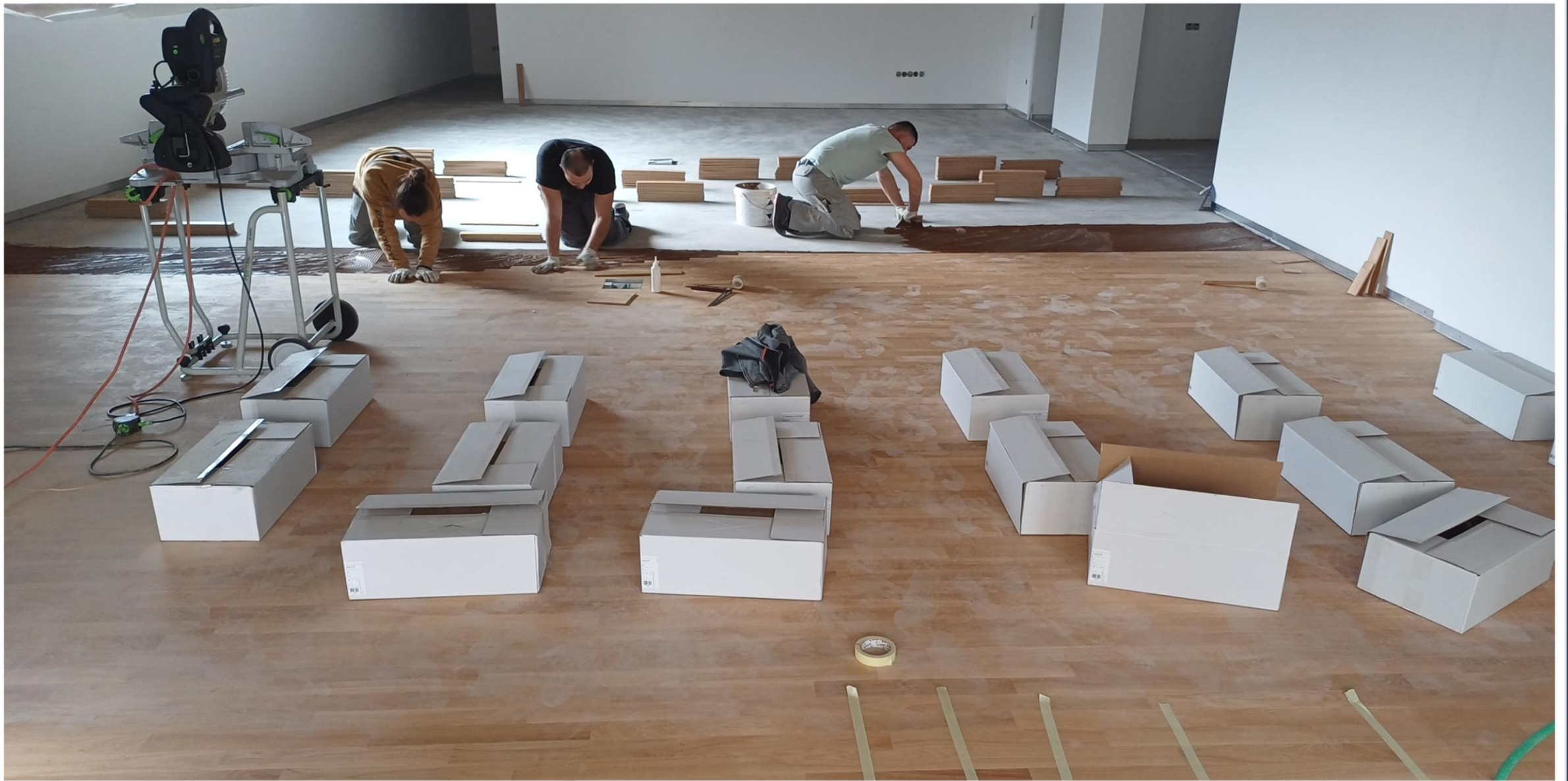
Verlegung des Parquet im Peter&Paul Saal Mitte März 2025
