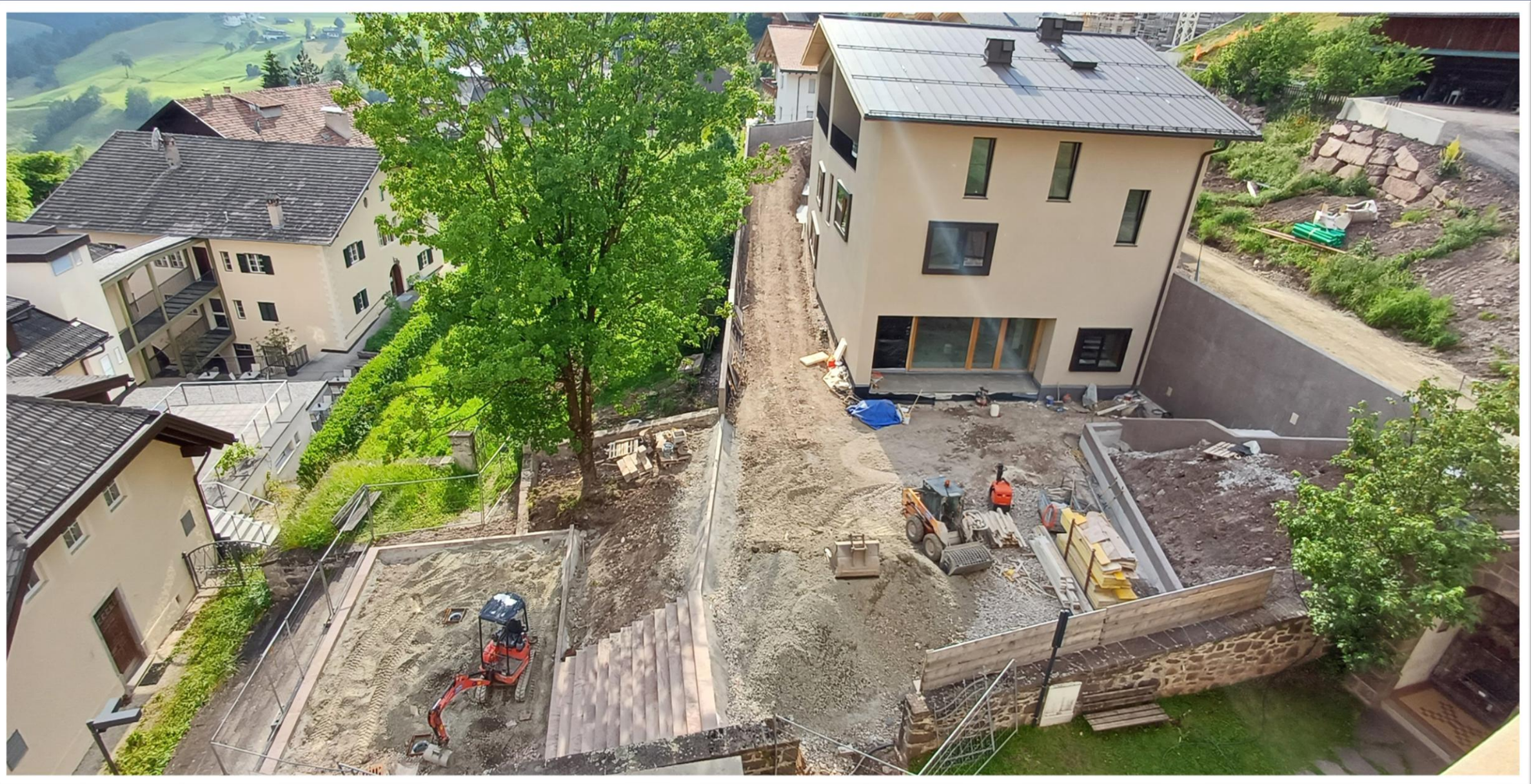
Gestaltung des Pfarrplatzes Mitte Juni 2025
