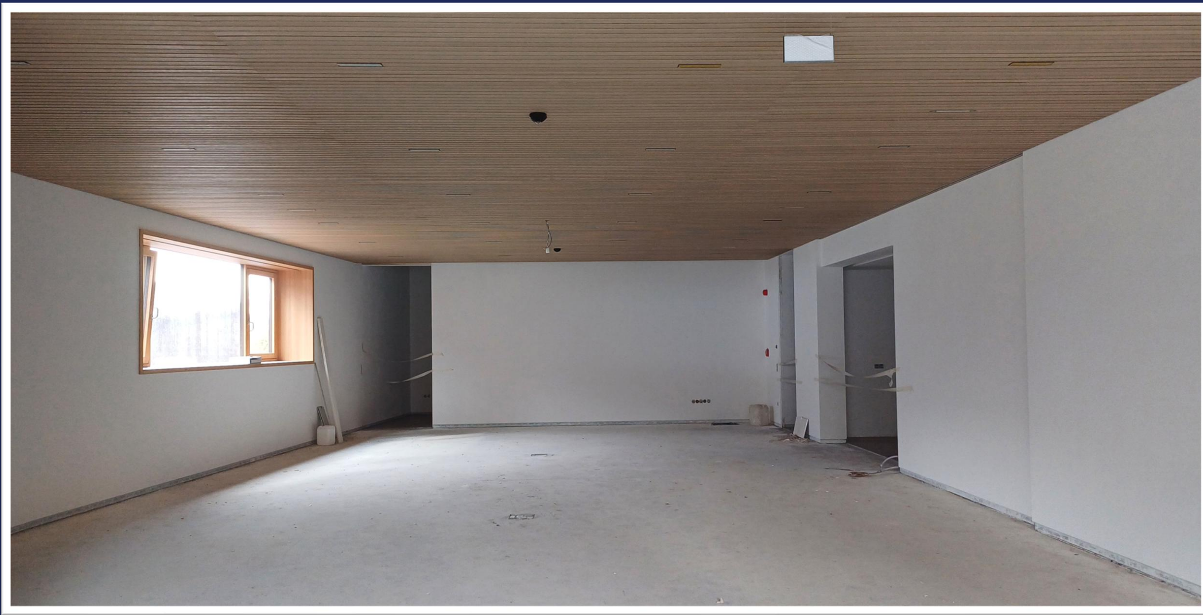
Fertigstellung der Akustikdecke im Peter&Paul Saal Anfang März 2025
