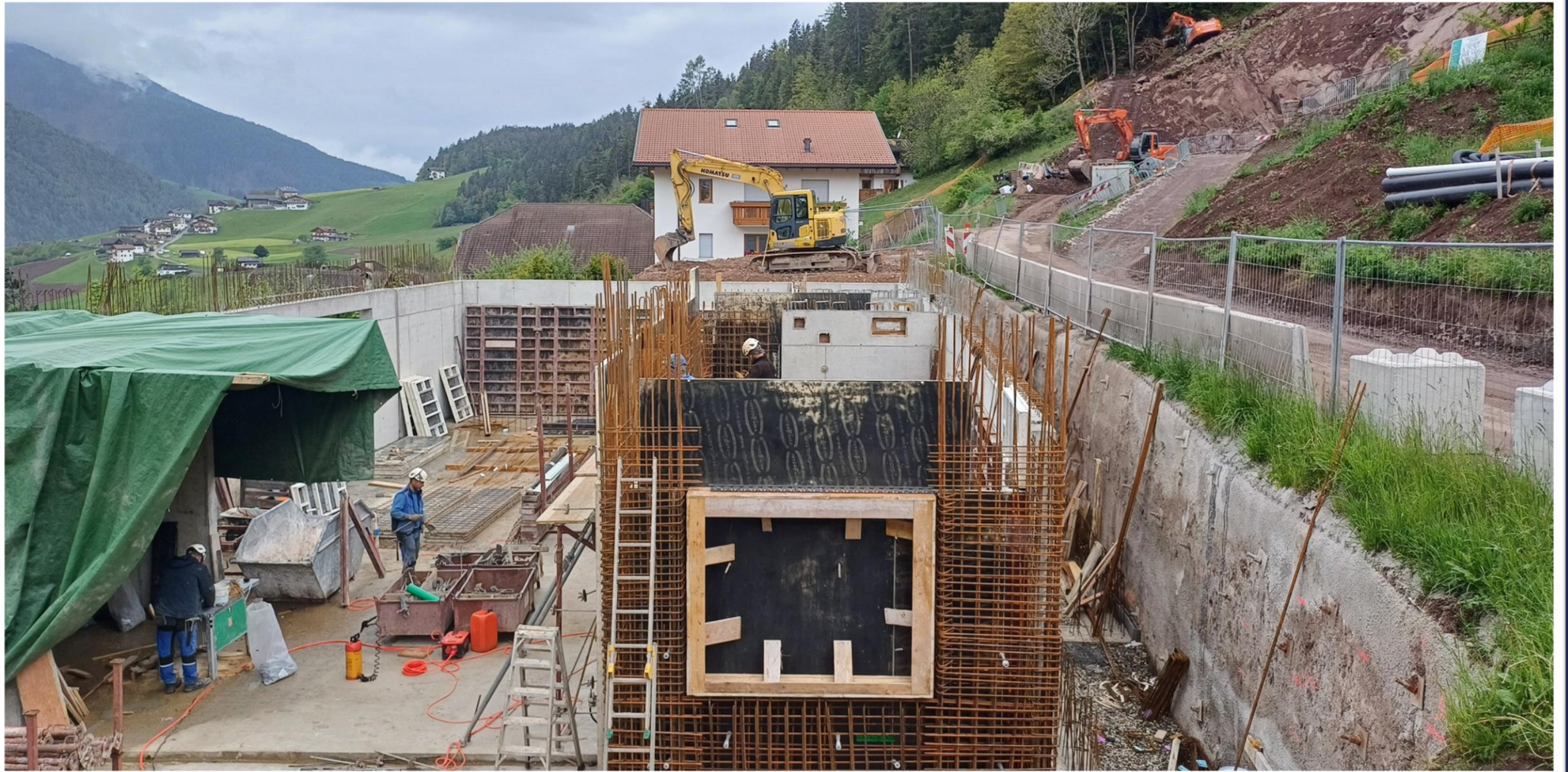
Einschalung der östlichen Außenwand am 15. Mai 2024
