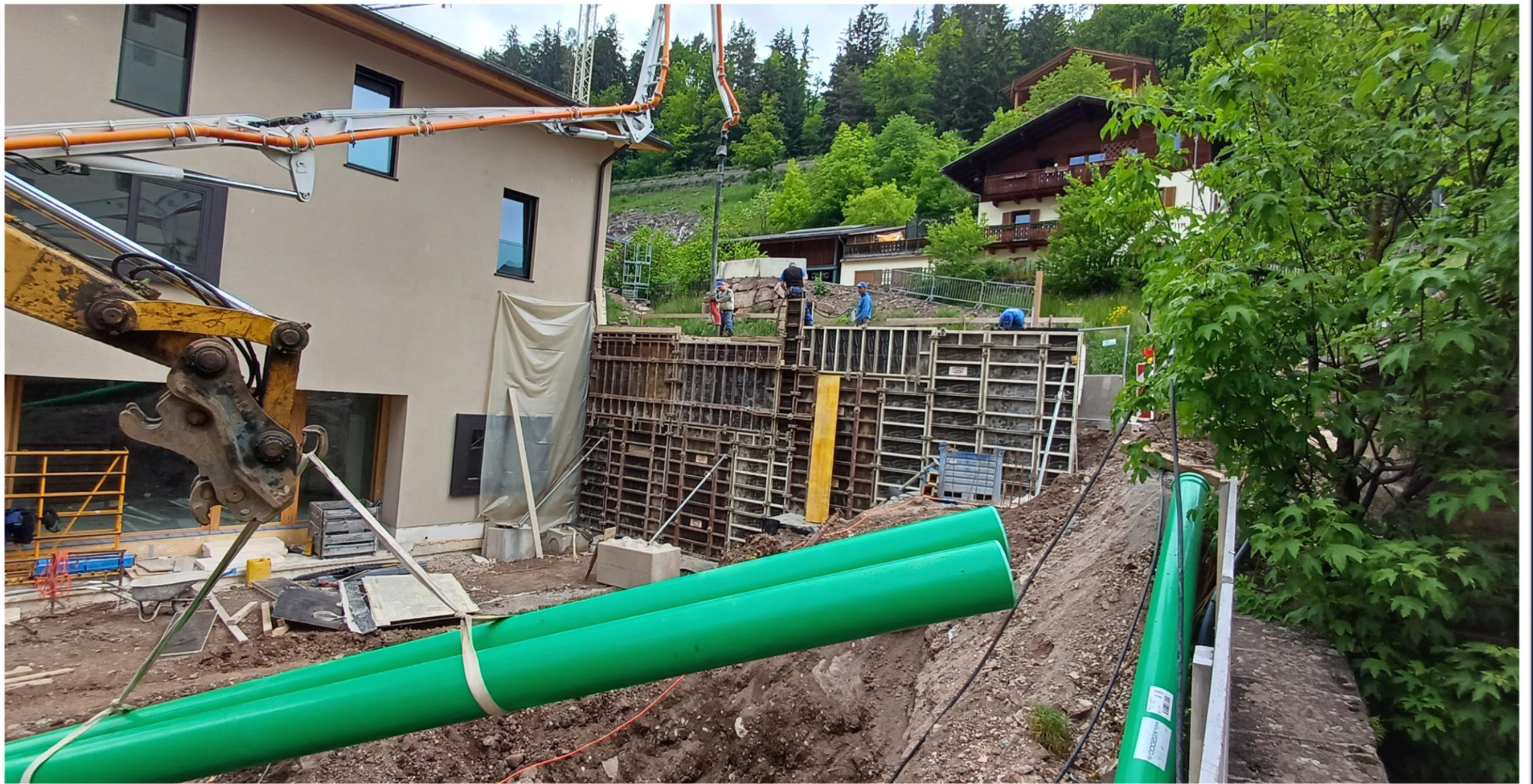
Gießen der Mauer zur Nordseite des Pfarrplatzes Mitte Mai 2025
