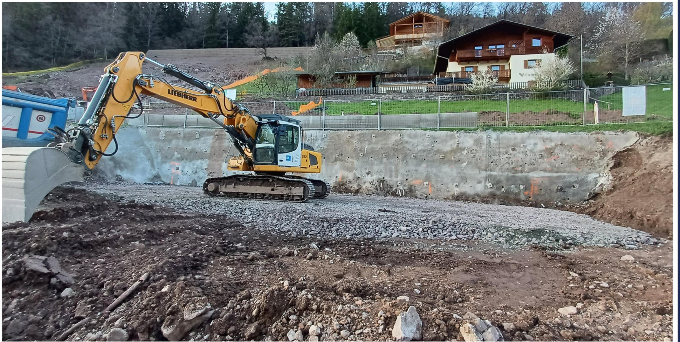
Schotterpaket unterhalb Fundamentplatte Mitte April 2024
