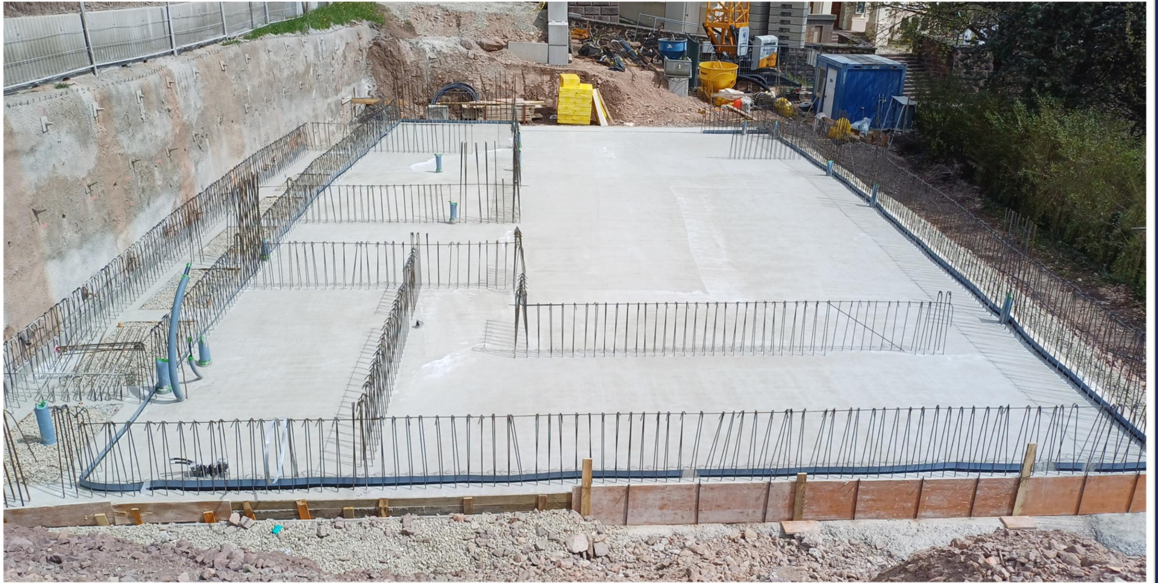
Fertigstellung der Fundamentplatte Ende April 2024
