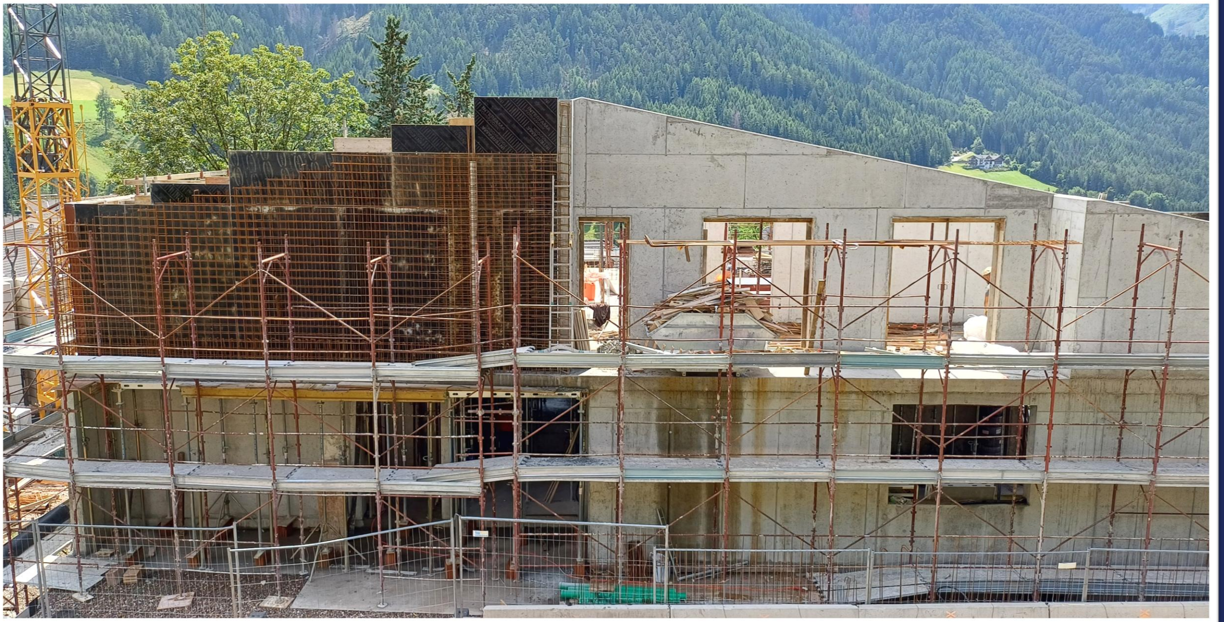
Aufbau der Wände im Obergeschoss Mitte Juli 2024
