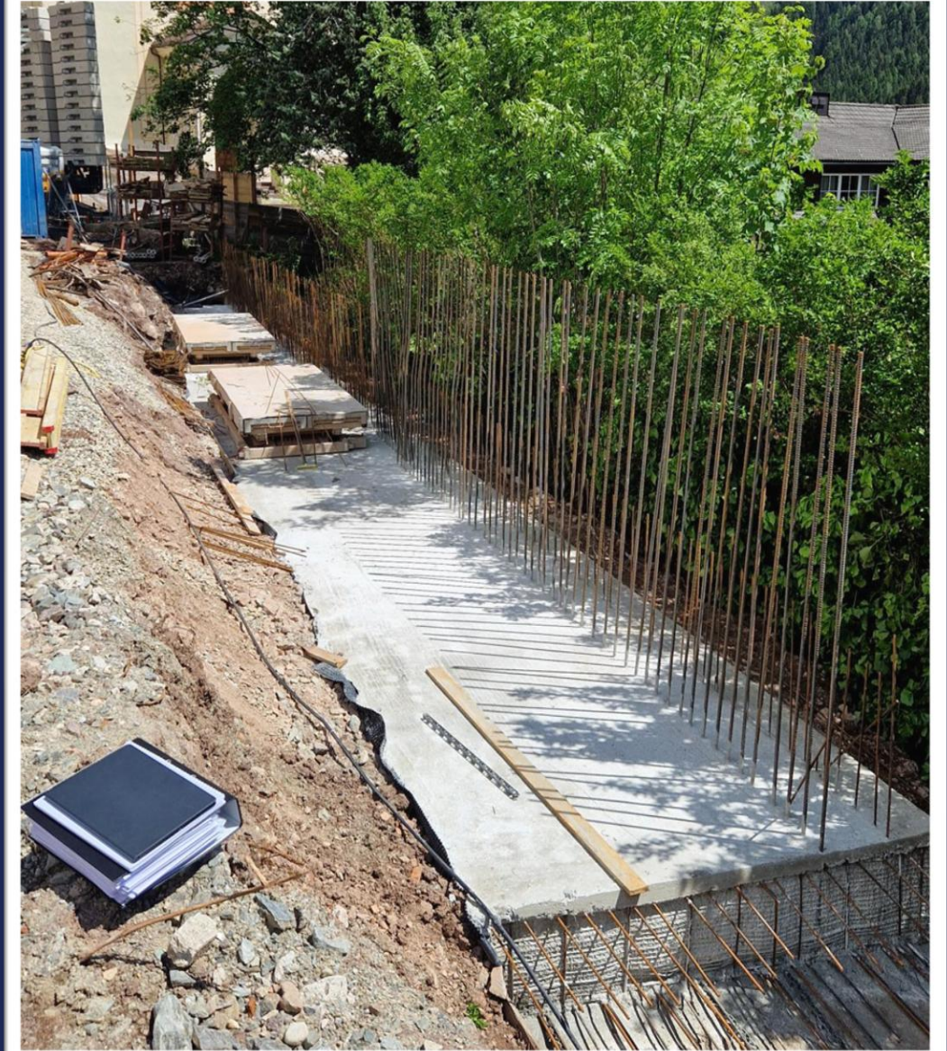
Gießen der Fundamente 1. Teil Rampe am 5. Juni 2024
