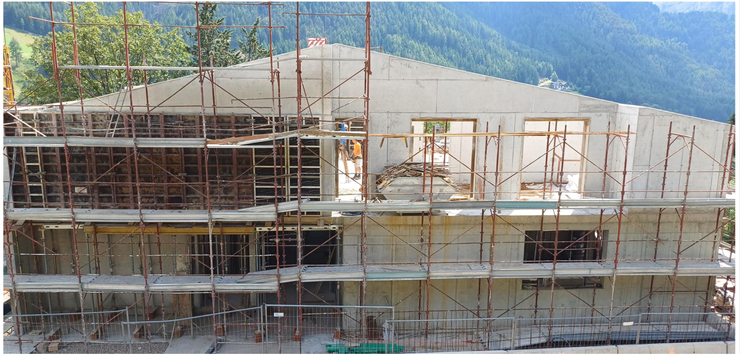
Aufbau der Wände im Obergeschoss Mitte Juli 2024
