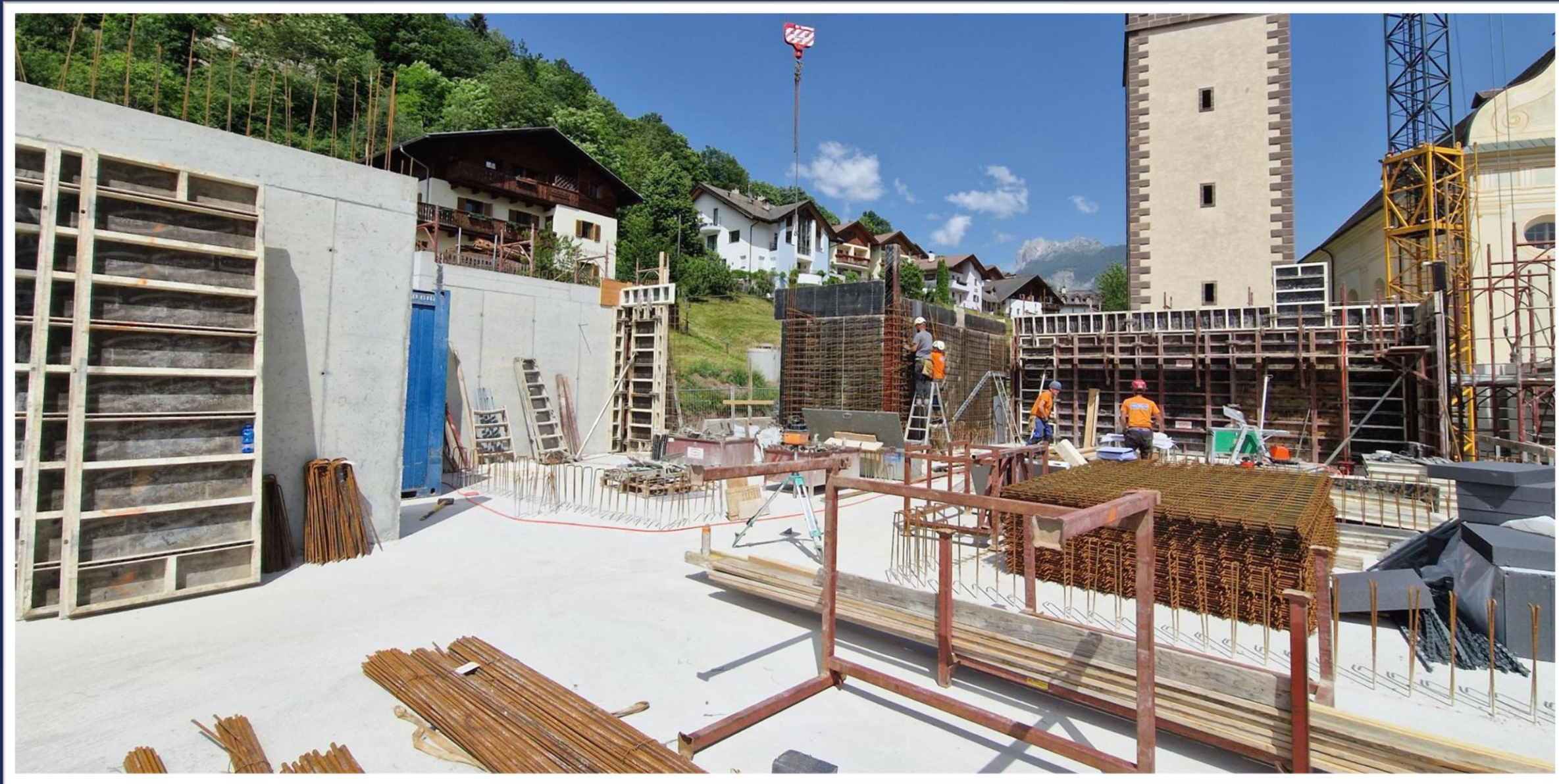
Aufbau der Wände im Untergeschoss Ende Juni 2024
