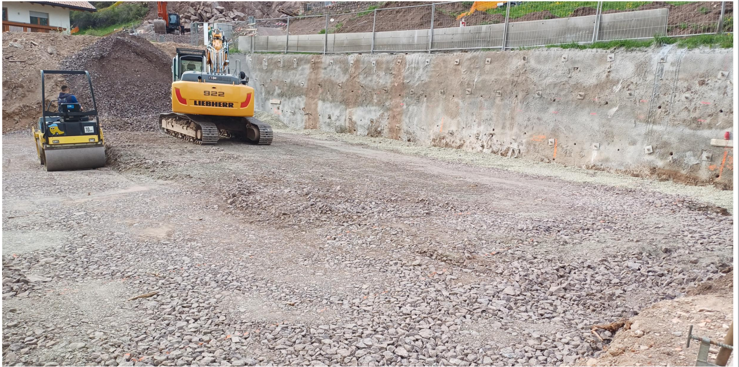
Schotterpaket unterhalb Fundamentplatte Mitte April 2024
