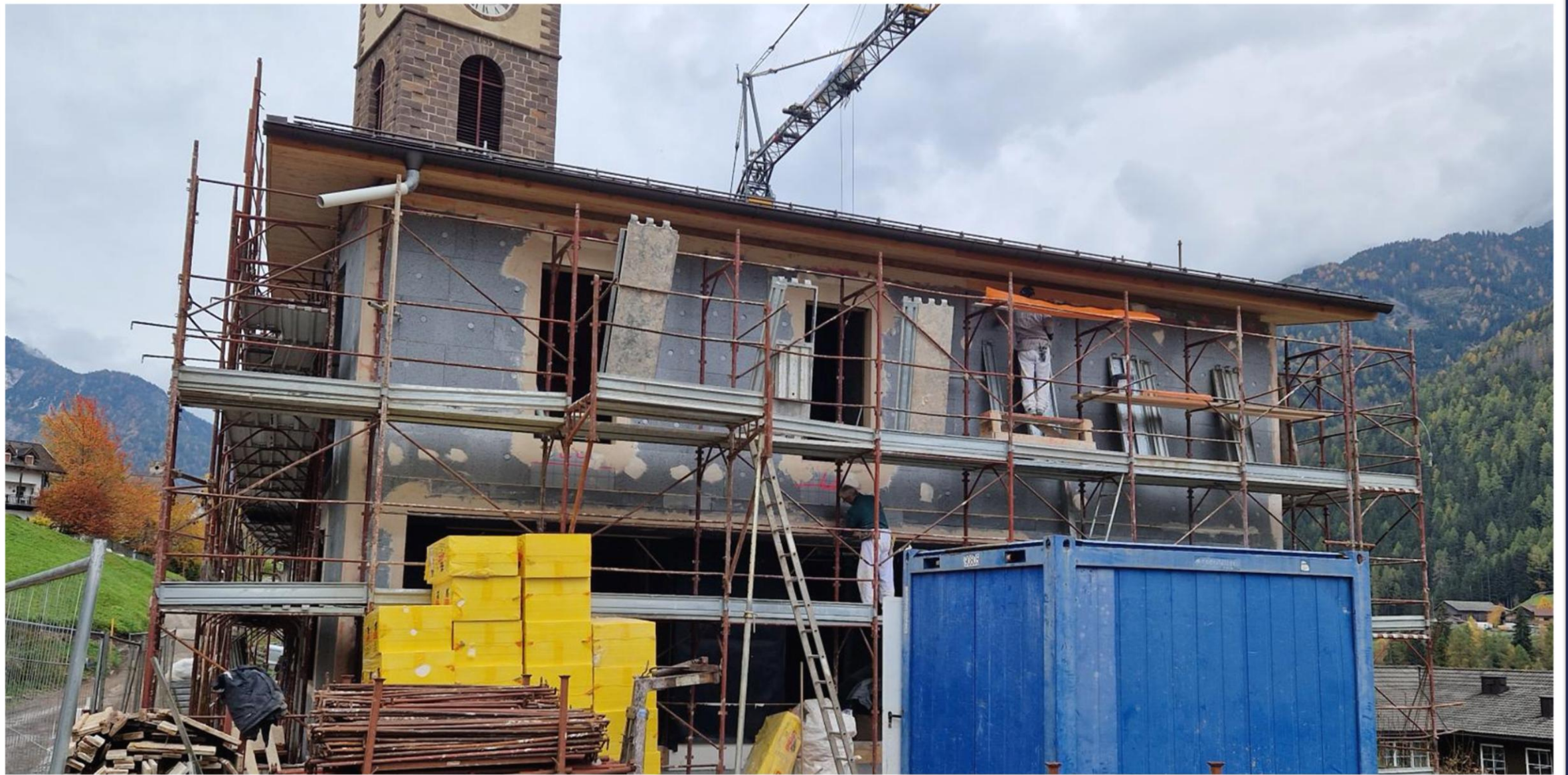
Außendämmung Anfang Oktober 2024
